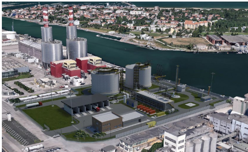
nuovo IMPIANTO GNL
