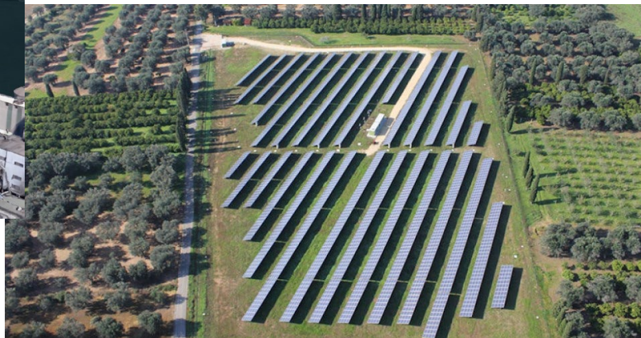
Nuovo IMPIANTO FOTOVOLTAICO e IDROGENO VERDE
