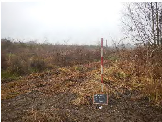
14. TRES FdR IDRO 2020. Settore meridionale del cantiere.
