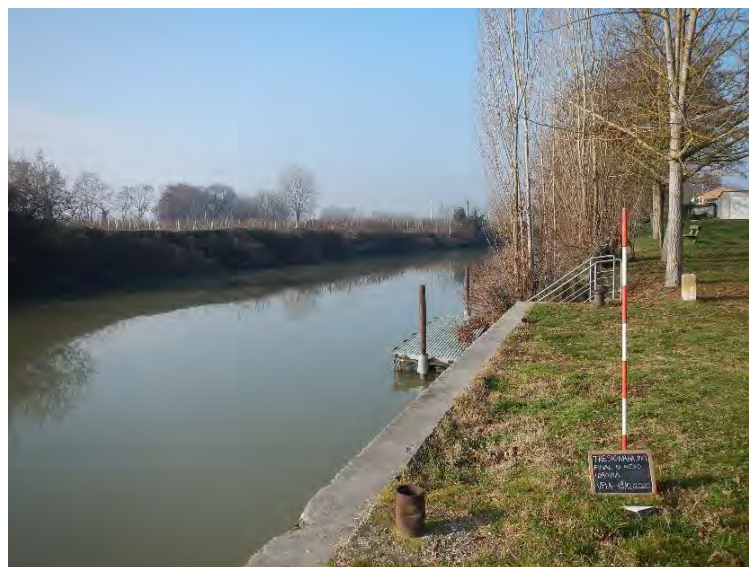
Fig.5.2 – Tresignana (FE). Banchina in riva sinistra a Nord del Ponte di Final di Rero Pace (19/12/2020)
