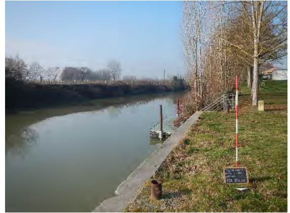
38. TRES FdR IDRO 2020. Banchina Nord a Final di Rero
