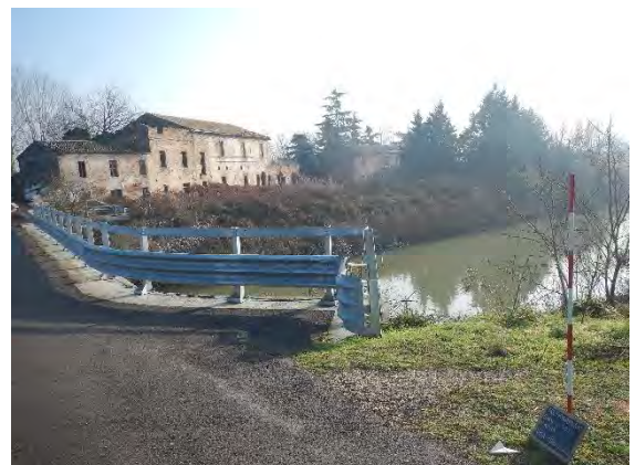
39. TRES FdR IDRO 2020. Conca di Valpagliaro, settore Nord
