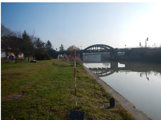
37. TRES FdR IDRO 2020. Banchina Nord a Final di Rero
