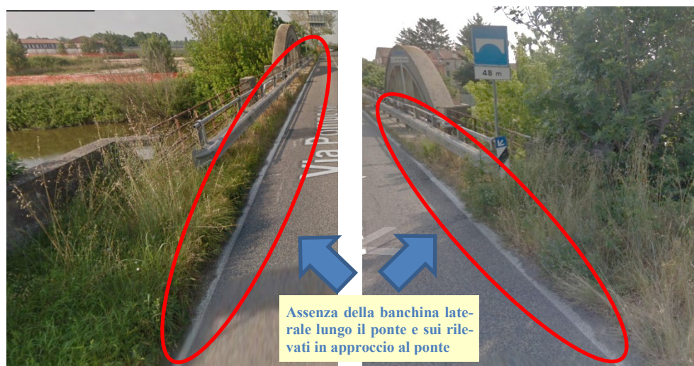
Foto 1 e Foto 2– Margine laterale in prossimità del ponte esistente
