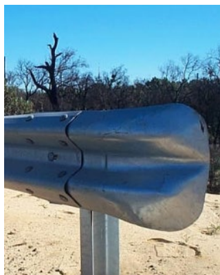
Figura 10: elemento terminale di fine impianto (tradizionale “a manina”)
