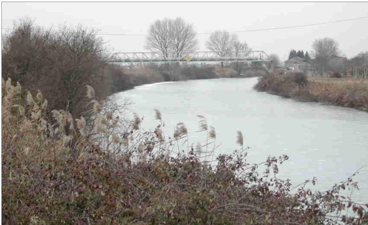
Figura 3 – Po di Volano a monte dell’abitato di Migliarino (vista da valle)
