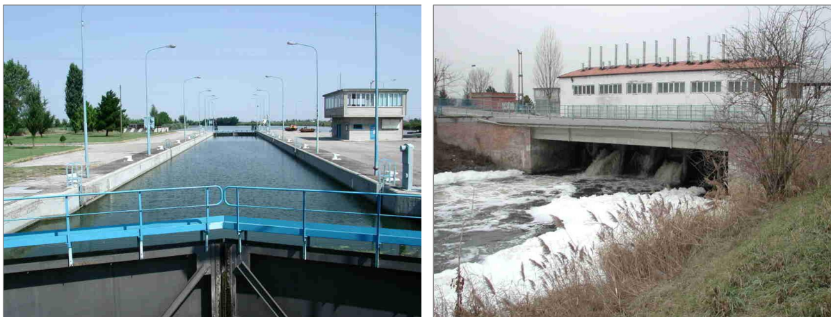
Figura 1 – Conca di navigazione presso il sostegno di Valpagliaro (immagine a sinistra) e sostegno di Valpagliaro (immagine a destra)
