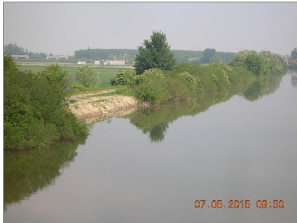
Figura 16 – Tratti di argine in cui sono stati già effettuati interventi di ripresa di frane e riprofilatura delle scarpate (immagini riprese il 07 maggio 2015, nell’ambito del progetto ADEGUAMENTO ARGINALE IN SPONDA DX E SX IDRAULICA DEL CANALE NAVIGABILE NEL TRATTO DA MIGLIARINO A OSTELLATO)
