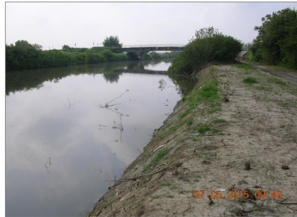
Figura 16 – Tratti di argine in cui sono stati già effettuati interventi di ripresa di frane e riprofilatura delle scarpate (immagini riprese il 07 maggio 2015, nell’ambito del progetto ADEGUAMENTO ARGINALE IN SPONDA DX E SX IDRAULICA DEL CANALE NAVIGABILE NEL TRATTO DA MIGLIARINO A OSTELLATO)
