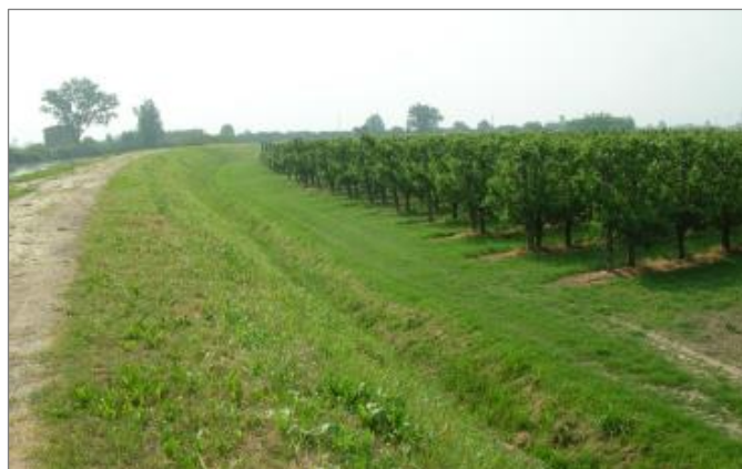
Figura 52 – Canale di scolo esistente ai piedi della scarpata lato campagna
