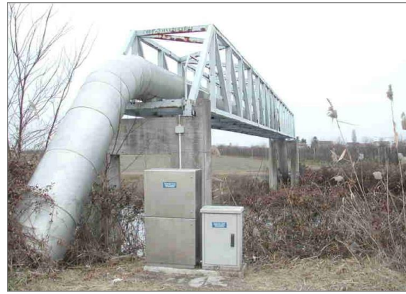
Figura 54 – Ponte tubo dell'acquedotto del Copparo
