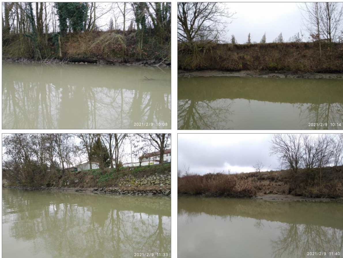
Figura 14 – Riprese della sponda fluviale del Po di Volano nel tratto oggetto degli interventi di rifunzionalizzazione idroviaria. Le riprese sono state effettuate durante sopralluogo in data 9 febbraio 2021
