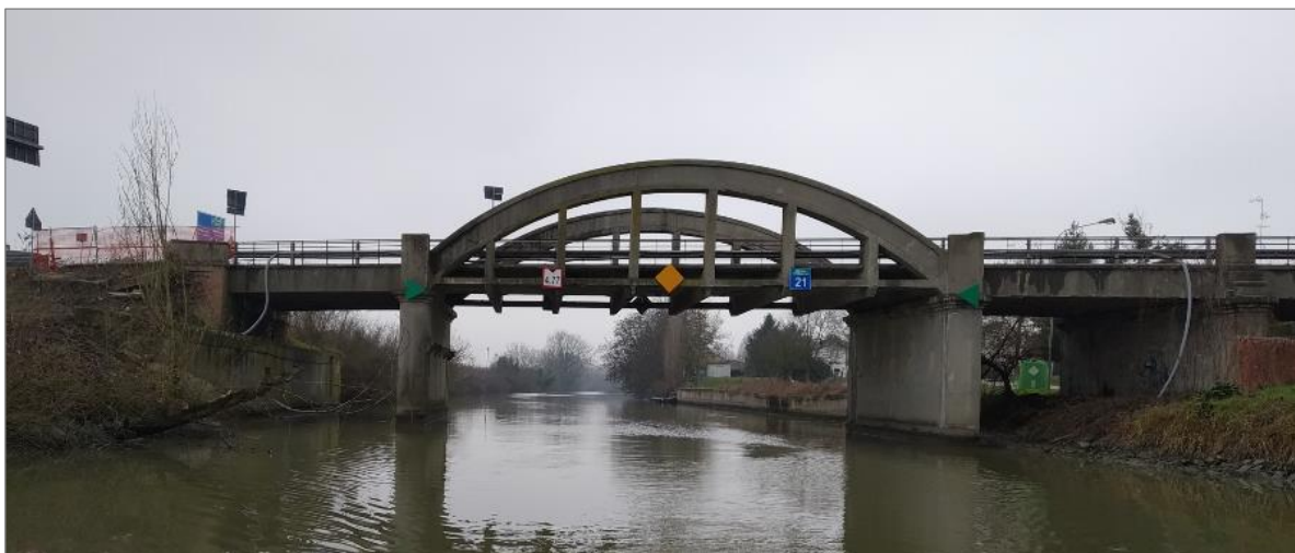
Figura 12 – Ripresa del vecchio ponte di Final di Rero
