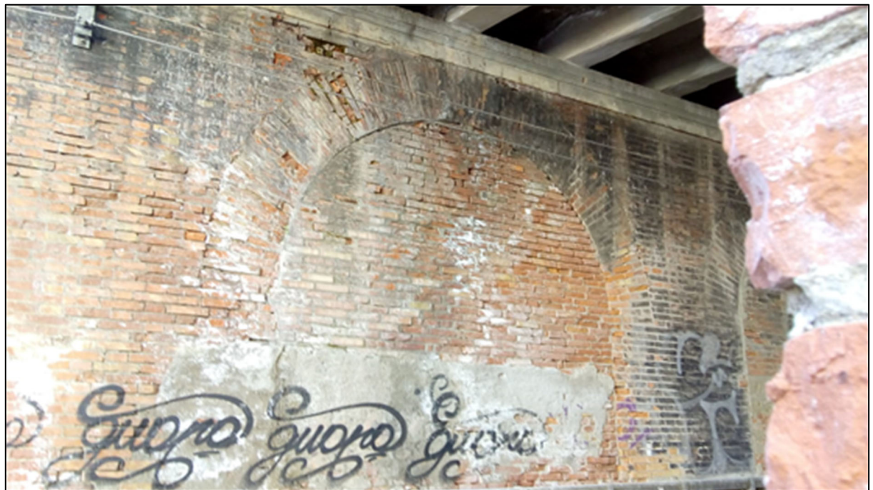
Figura 71: Vista del ponte dall'attuale sedime ferroviario
