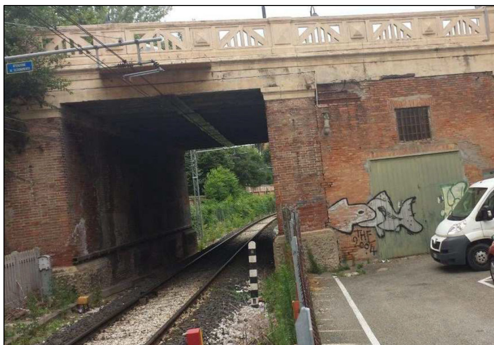
Figura 69: Vista del ponte Bentivogli dalla linea ferroviaria lato est (in direzione Bologna)
