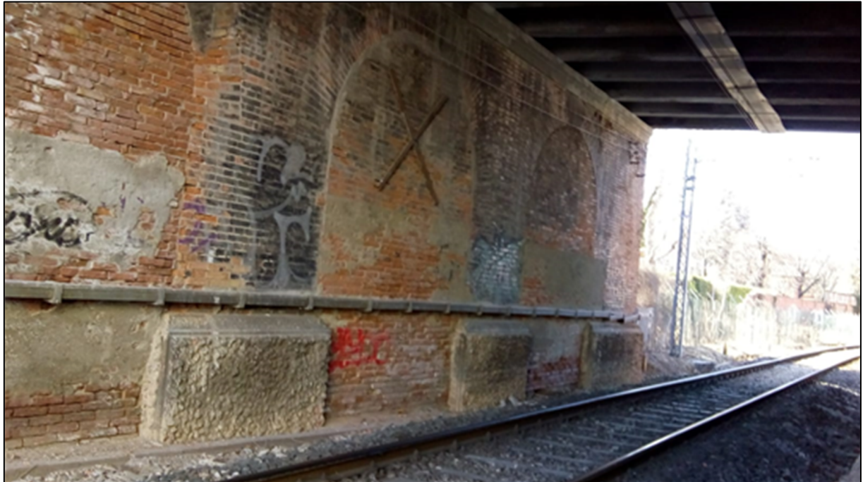
Figura 70: Vista del ponte dall'attuale sedime ferroviario
