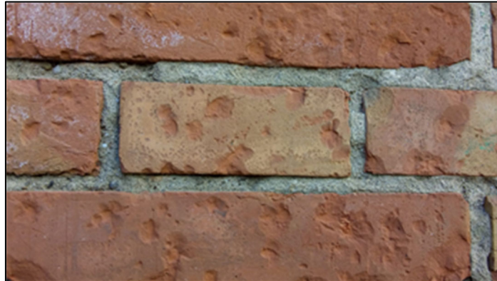
Figura 72: Particolare della muratura portante del ponte
