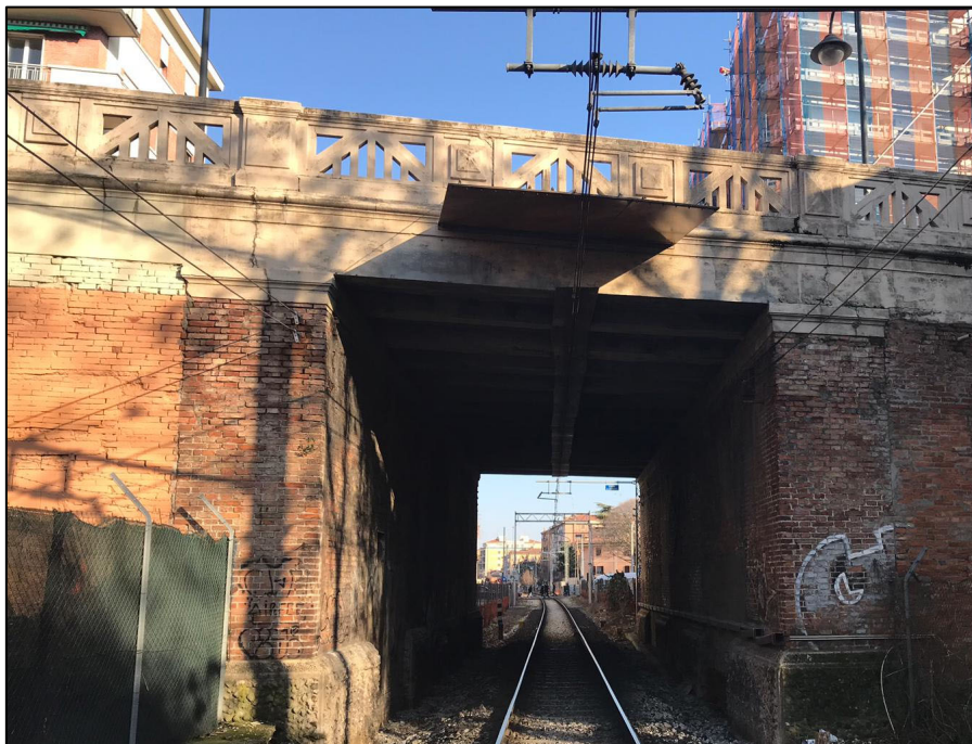
Figura 68: Vista del ponte Bentivogli dalla linea ferroviaria lato Ovest (in direzione Portomaggiore)
