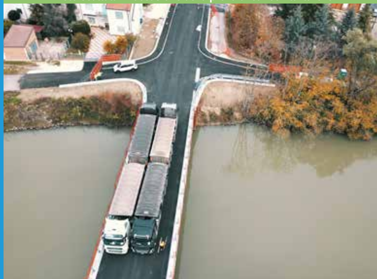
Foto scattata in occasione della prova di carico 18/10/2020
