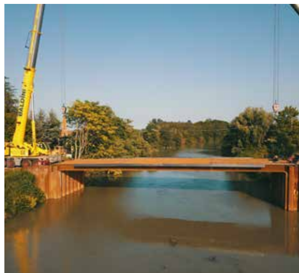
Foto del posizionamento dell'impalcato (03/07/2020)
