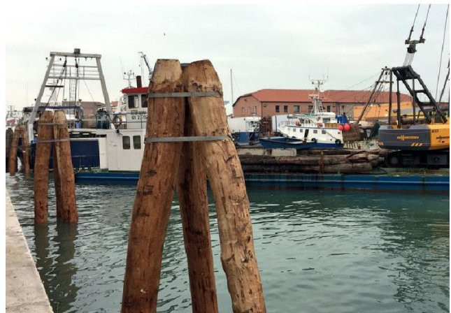
Posizionamento di n. 2 gruppi di briccole ognuno di 4 elementi, per delimitazione dei lavori di demolizione delle spalle. Ogni briccola è formata da n.3 pali lunghi circa 10 m, di diametro \varnothing minimo 30 cm e affioranti dal pelo dell'acqua di almeno 1.5 m dotata dell'opportuna segnaletica e luci lampeggianti notturne.
