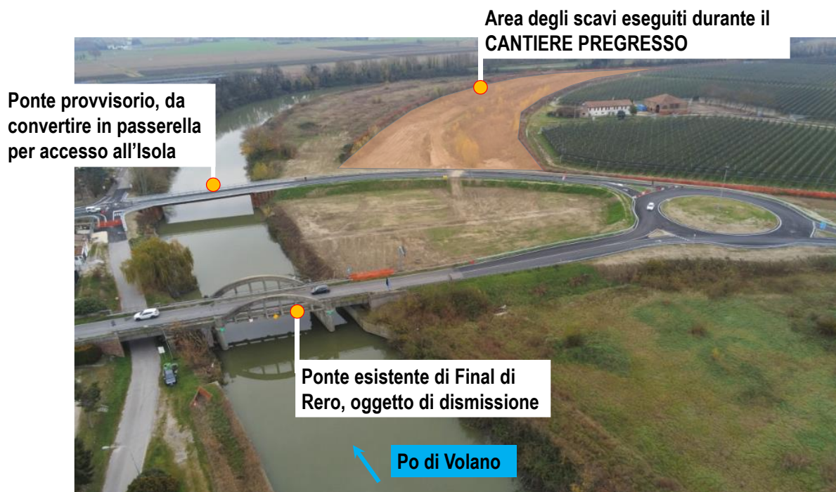
Figura 2 – Ripresa fotografica da drone dello stato esistente con evidenza della viabilità stradale e degli scavi parziali già realizzati
