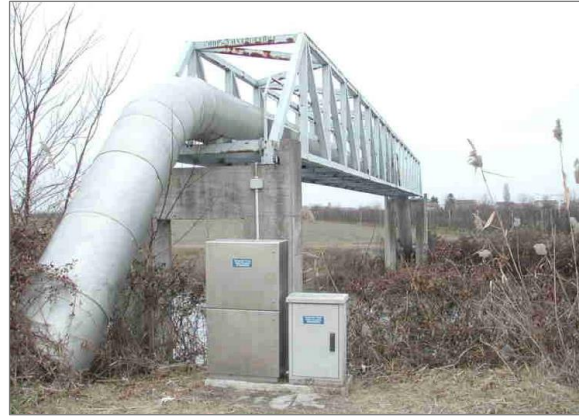
Figura 2 – Ponte tubo dell'acquedotto del Copparo
