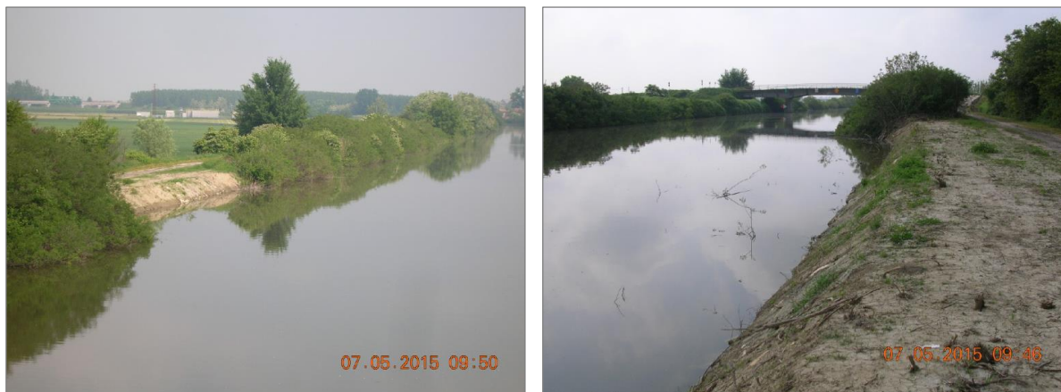
Figura 5 – Tratti di argine in cui sono stati già effettuati interventi di ripresa di frane e riprofilatura delle scarpate (immagini riprese il 07 maggio 2015, nell’ambito del progetto ADEGUAMENTO ARGINALE IN SPONDA DX E SX IDRAULICA DEL CANALE NAVIGABILE NEL TRATTO DA MIGLIARINO A OSTELLATO)
