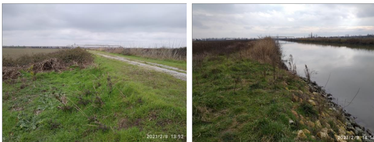
Figura 6 – Riprese effettuate durante il sopralluogo svolto in data 09 febbraio 2021 lungo il tratto di canale Migliarino-Ostellato
