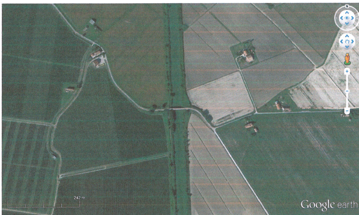
Fig.2.1 - Immagine Google Earth (accesso 11/04/2019) Migliarino (FE) – Ponte Madonna
