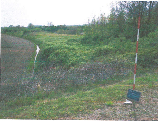
14. MPM. Spalla Sudest, prospettiva argine
