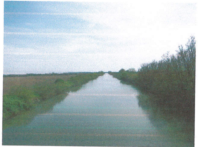
4. MPM. Idrovia Ferrarese, a Sud del ponte
