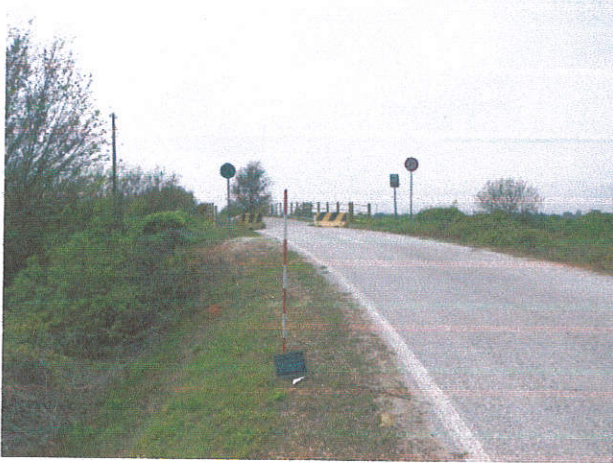
13. MPM. Rampa lato Est
