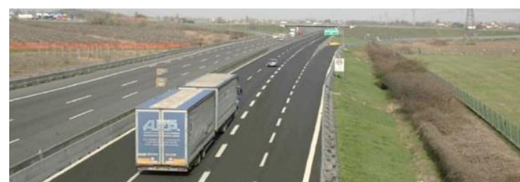
Doppia carreggiata con tre corsie L=3.75m ed emergenza L=3.00m. Banchine interne da 0.70m e spartitraffico da 2.60m. Ampliamento totale 9,80m.
