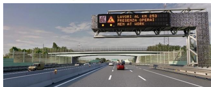
Doppia carreggiata con tre corsie L=3.75m ed emergenza L=3.00m. Banchine interne da 0.70m e spartitraffico da 2.60m. Ampliamento totale 9,80m.
