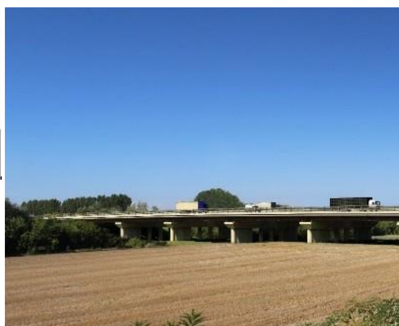
Doppia carreggiata con tre corsie L=3.75m ed emergenza L=3.00m. Banchine interne da 0.70m e spartitraffico da 2.60m. Ampliamento totale 9,80m.
