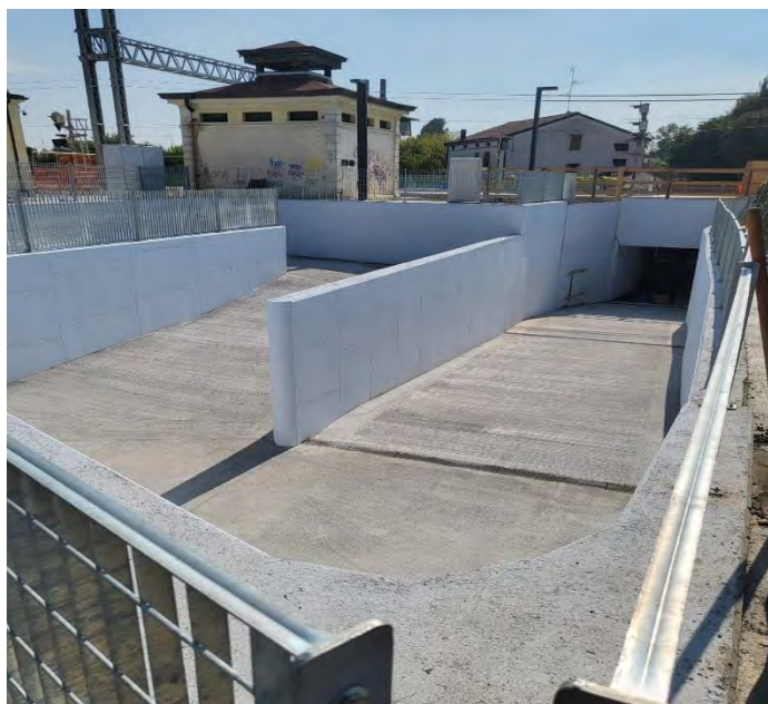
Figura 109 Stazione di Guastalla
