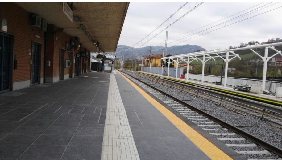
Stazione di Vergato - Lavori in corso
