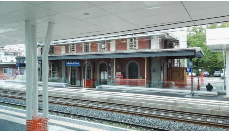
Stazione di S. Ilario d'Enza - Lavori in corso
