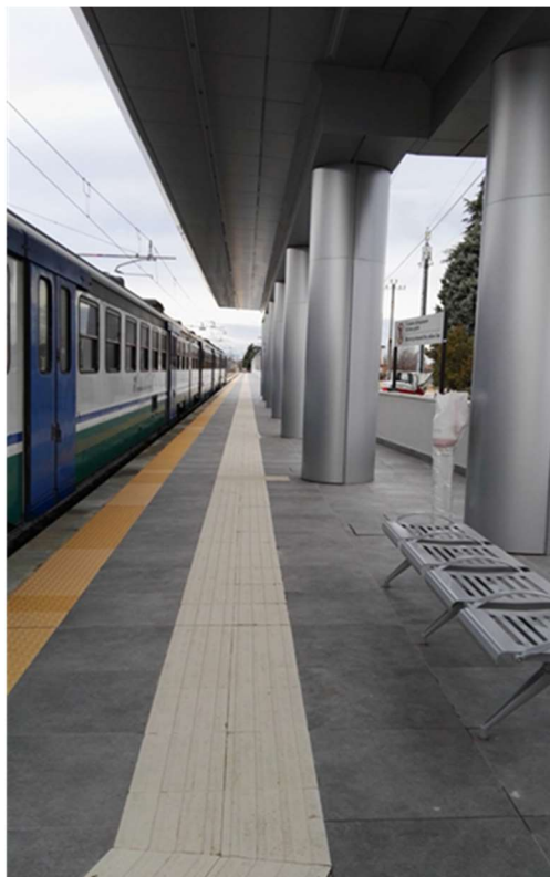
Stazione di Imola nuovo marciapiede
