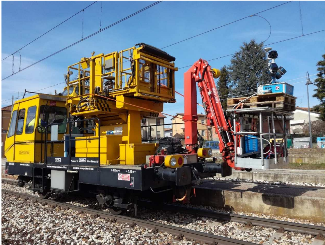
Rilievo MMS Road-Scanner sulla linea ferroviaria
