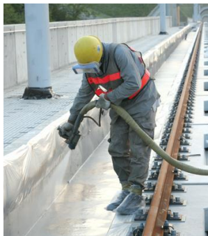
Figura 12.8.4.2.6.a - Applicazione a spruzzo della membrana impermeabile
