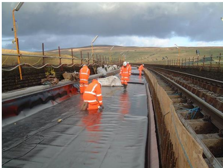
Figura 12.8.4.2.2 - Lavorazione con il 2° binario in affianco sostenuto
