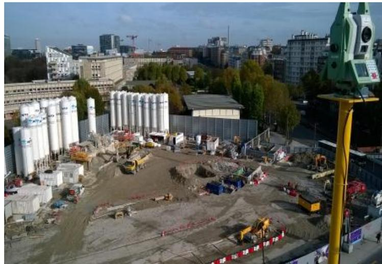
**Figura 5: Stazione totale robotizzata – postazione fissa su supporto predisposto**
