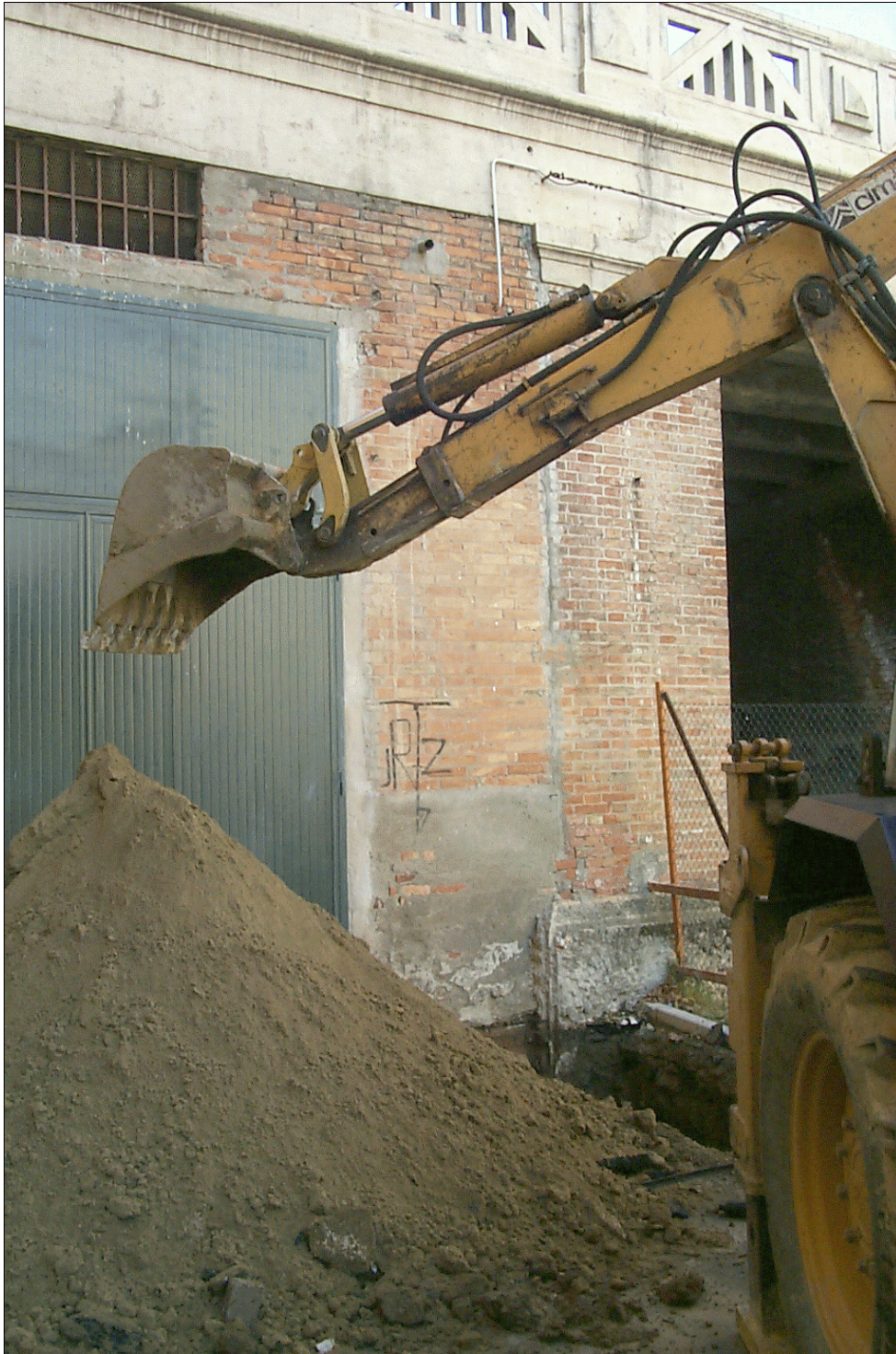
FOTO 24: Spalla sud del cavalcaferrovia di Via Bentivogli.
