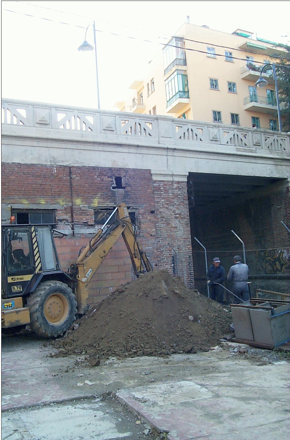
FOTO 22: Spalla nord cavalcaferrovia di Via Bentivoglio.
