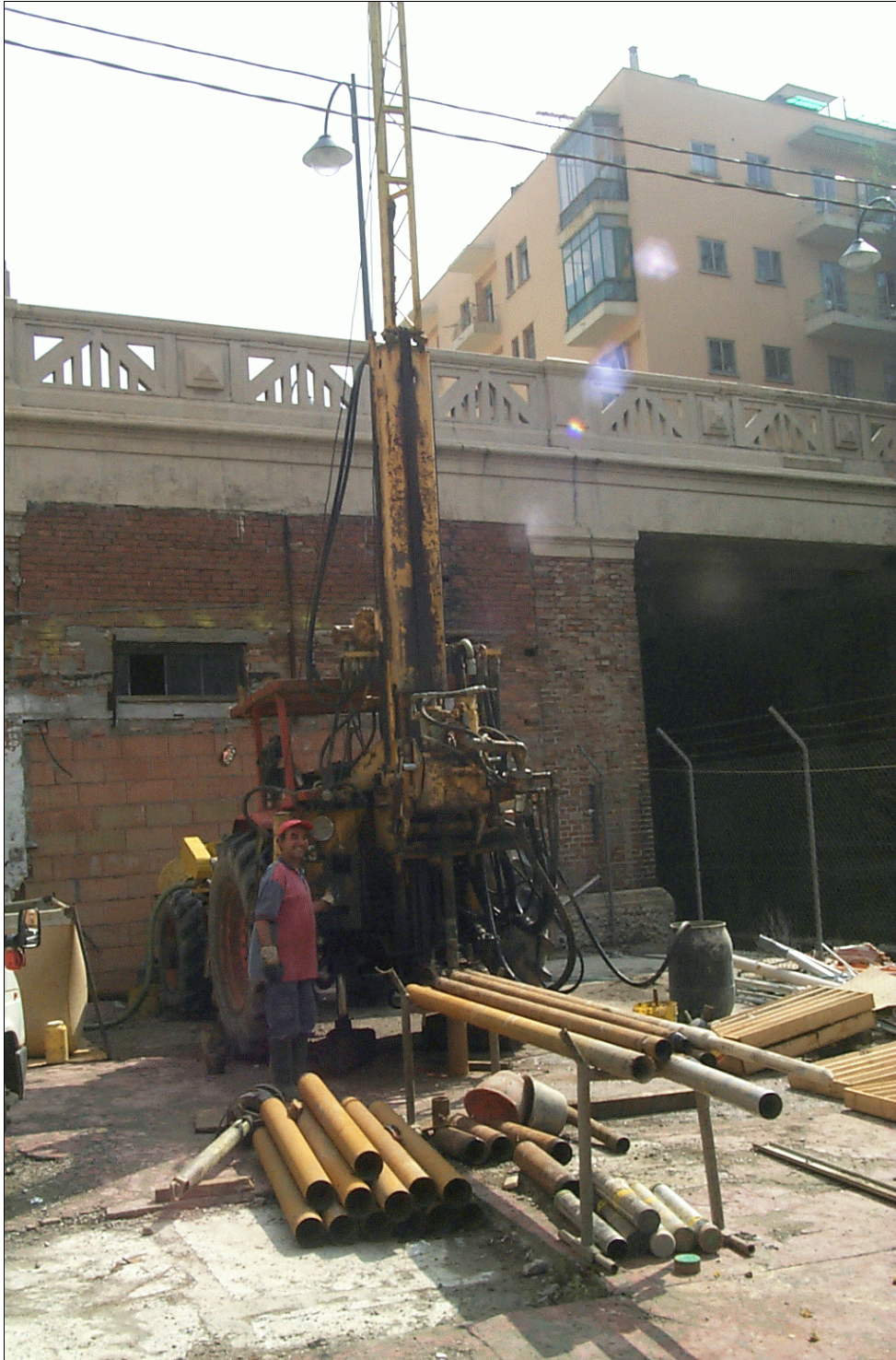
FOTO 1: Ubicazione del sondaggio n° 1
