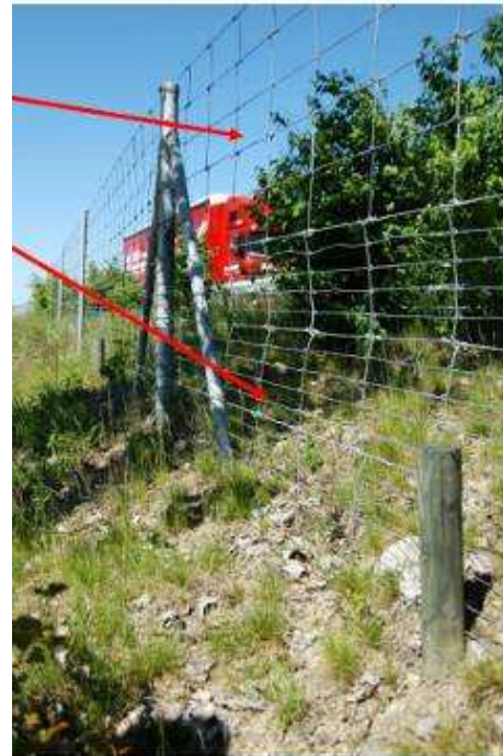
Figura 1.21 - Esempio di rete a maglia diversificata posta lungo una strada ad intenso traffico per evitare l'attraversamento
