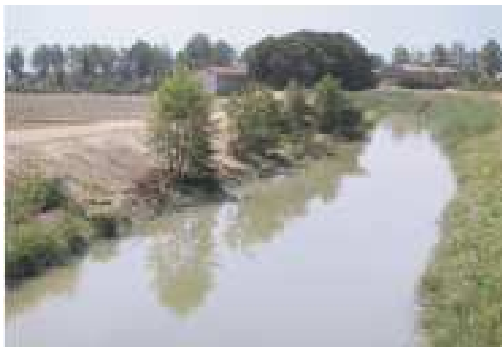
Figura 3.2 - Esempio di manutenzione effettuata preservando una serie di ontani presenti sulla sponda.
