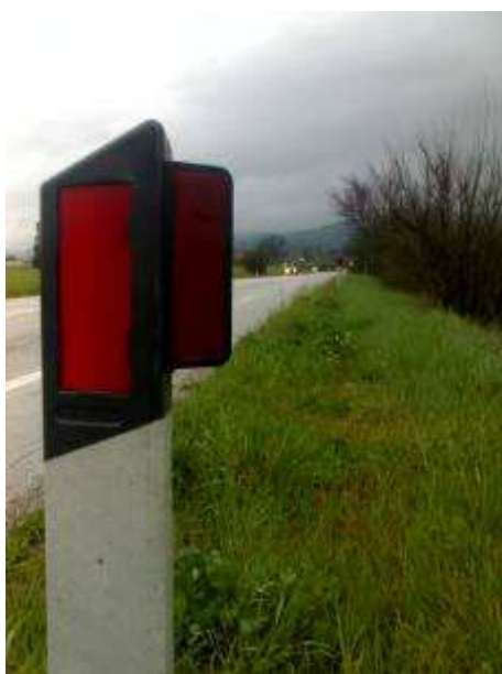
Figura 1.23 - Dissuasore riflettente per la fauna selvaggina montato su paracarro lungo una strada provinciale.
