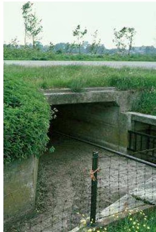
Figura 1.9 - Esempio di sottopasso a sezione rettangolare; la pavimentazione in cemento rende il sottopasso meno gradevole alla fauna- Infra Eco Network Europe
