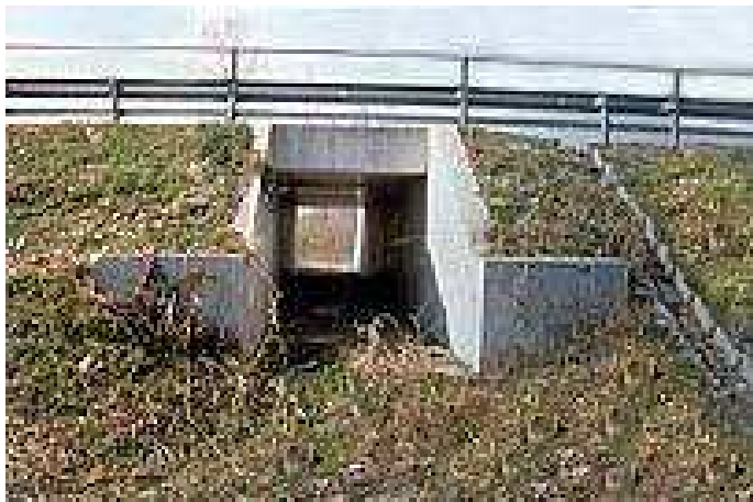
Figura 1.8 - Esempio di sottopasso rettangolare in cui è necessario inserire fasce di vegetazione laterali che fungano da elementi di invito verso il passaggio- Infra Eco Network Europe
