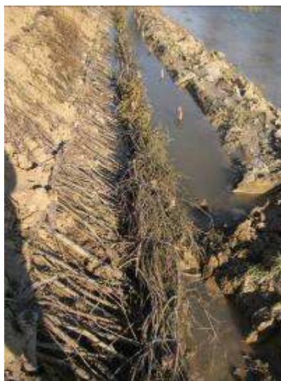
Fig. 2.4 - Esempio di copertura diffusa con ramaglia viva applicata lungo le sponde della parte terminale del Fiume Uso (RN)
