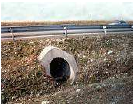
Figura 1.1 - Esempio di sottopasso faunistico (non completamente funzionale) per piccola media fauna - Infra Eco Network Europe
