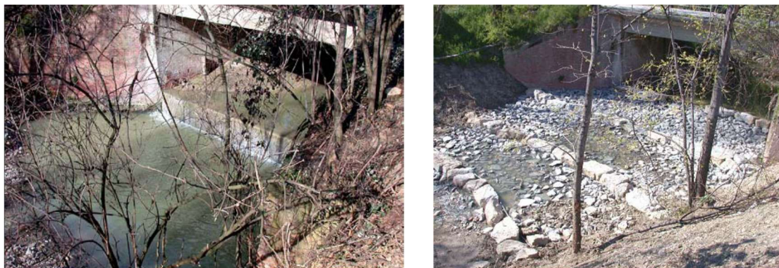
Figura. Esempio di costruzione di rampa in pietrame in Valsellustra (da Pianificazione e realizzazione di metodi integrati per il recupero del bacino idrografico della Val Sellustra, Comune di Dozza).
