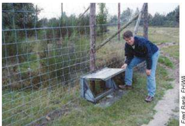
Figura. Esempio di cancelletto con apertura unidirezionale (da FHWA).
