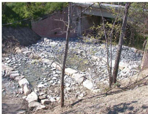
Figura. Esempio di costruzione di rampa in pietrame in Valsellustra (da Pianificazione e realizzazione di metodi integrati per il recupero del bacino idrografico della Val Sellustra, Comune di Dozza).
