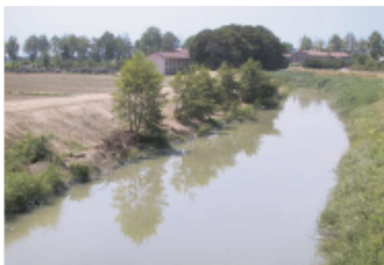
Figura. Esempio di manutenzione effettuata preservando una serie di ontani presenti sulla sponda.
