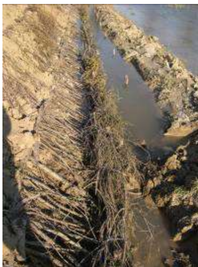
Figura. Esempio di copertura diffusa con ramaglia viva applicata lungo le sponde della parte terminale del Fiume Uso (RN).
