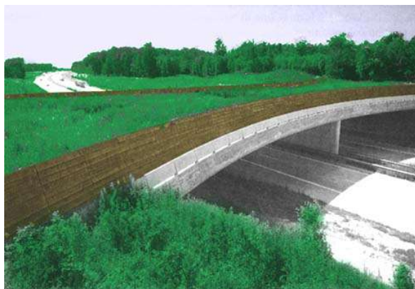
Figura. Esempio di sovrappasso su un'autostrada (da Infra Eco Network Europe).
