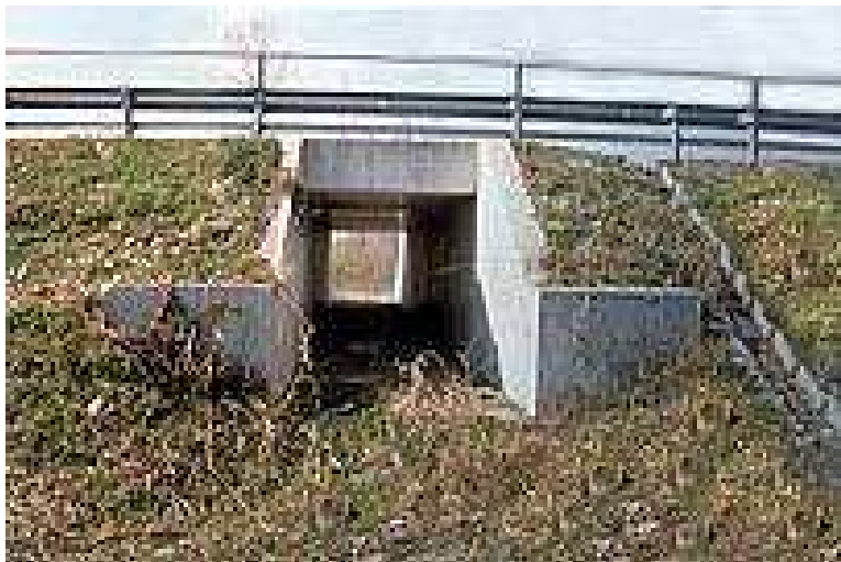
Figura. Esempio di sottopasso rettangolare in cui è necessario inserire fasce di vegetazione laterali che fungano da elementi di invito verso il passaggio (da Infra Eco Network Europe).
