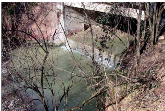
Figura. Esempio di costruzione di rampa in pietrame in Valsellustra (da Pianificazione e realizzazione di metodi integrati per il recupero del bacino idrografico della Val Sellustra, Comune di Dozza).
