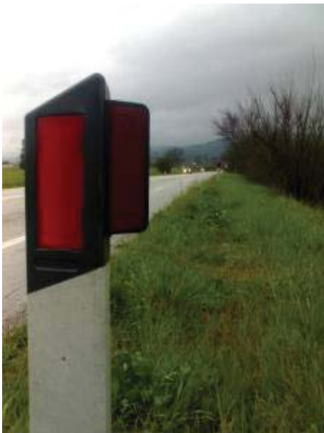
Figura 0.23 - Dissuasore riflettente per la fauna selvatica montato su paracarro lungo una strada provinciale.
