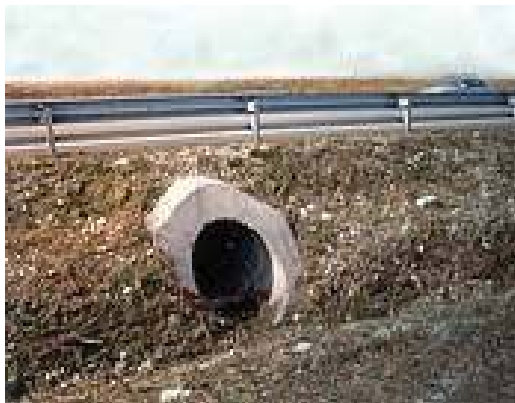
Figura 0.1 - Esempio di sottopasso faunistico (non completamente funzionale) per piccola media fauna - Infra Eco Network Europe
