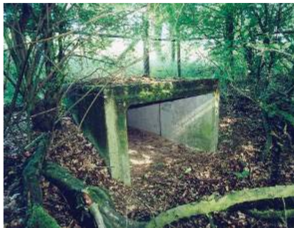
Figura 0.7 - - Esempio di sottopasso a sezione rettangolare- Infra Eco Network Europe
