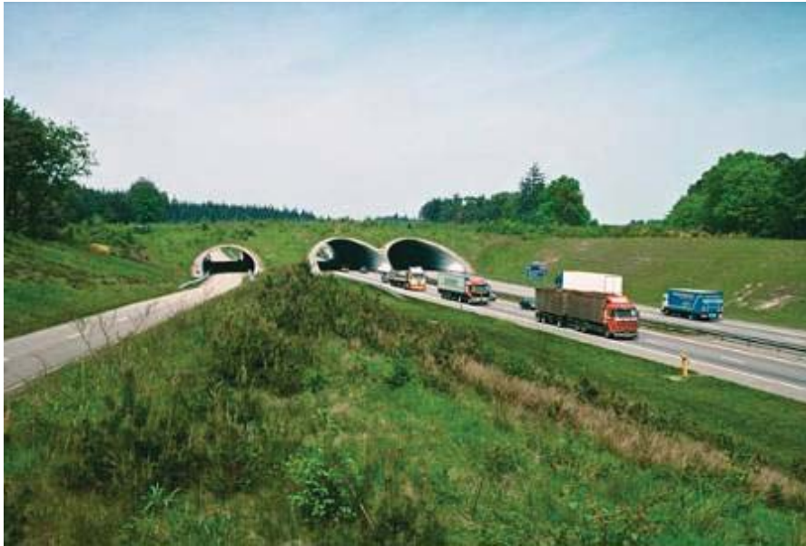
Figura 0.11 - Esempio di ecodotto- Infra Eco Network Europe
