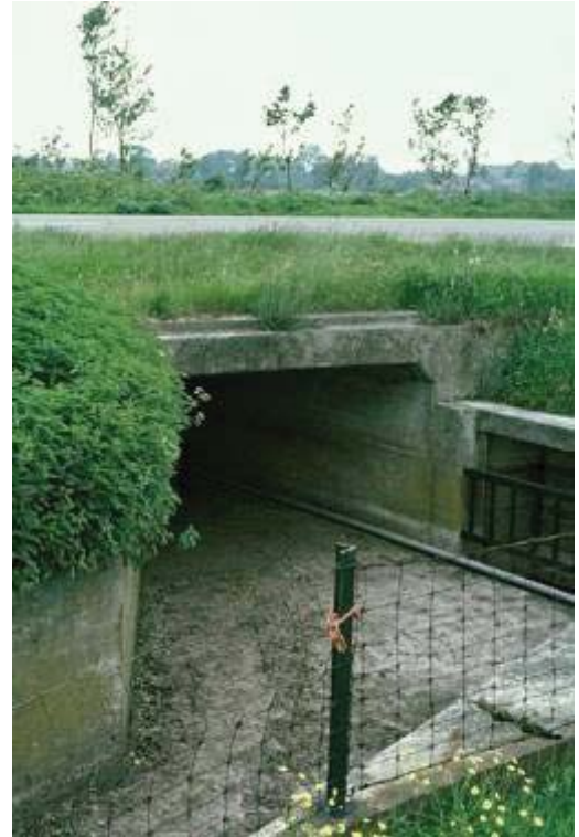
Figura 0.9 - Esempio di sottopasso a sezione rettangolare; la pavimentazione in cemento rende il sottopasso meno gradevole alla fauna- Infra Eco Network Europe
