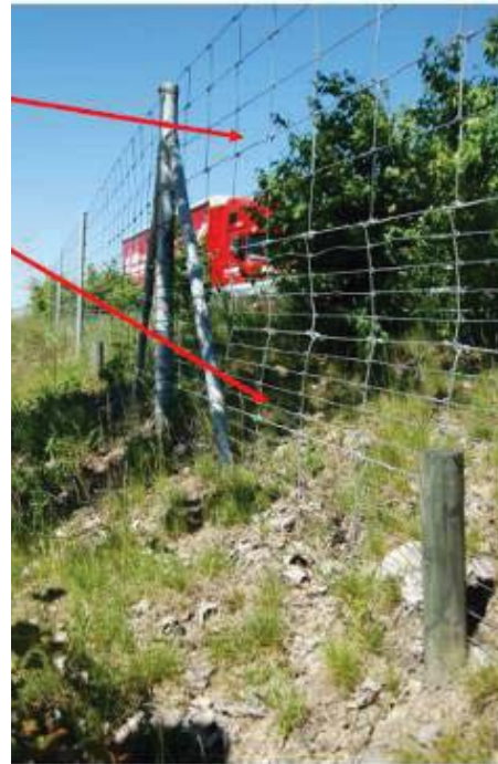
Figura 0.21 - Esempio di rete a maglia diversificata posta lungo una strada ad intenso traffico per evitare l'attraversamento
