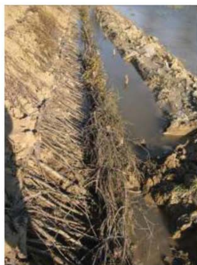
Fig. 0.30 - Esempio di copertura diffusa con ramaglia viva applicata lungo le sponde della parte terminale del Fiume Uso (RN)
