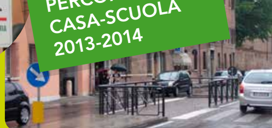
Realizzazione dell'attraversamento Dosso Dossi in Corso Biagio Rossetti
