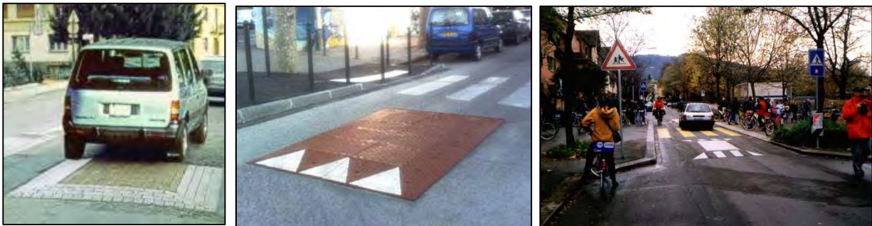
Esempi di cuscinio berlinese: il dispositivo di moderazione permette il passaggio in piano dei veicoli a due ruote.
