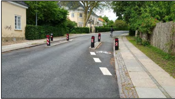
Copenaghen. Restringimento con percorso di aggiramento per le biciclette in entrambi i sensi.
